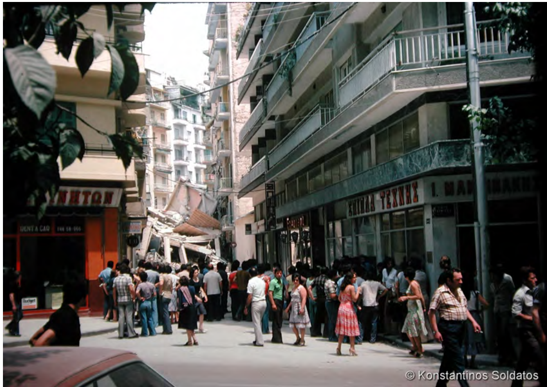
© Konstantinos Soldatos Τα ερείπια της μοιραίας πολυκατοικίας στην Πλατεία Ιπποδρομίου (το σημερινό Κέντρο Ιστορίας Θεσσαλονίκης). Οδός Γ. Θεοχάρη.
